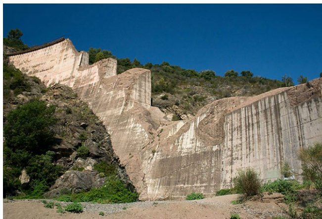
Fig. 8. Rupture du barrage de Malpasset, en amont de Fréjus
