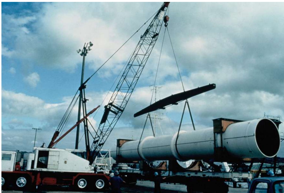
Fig. 7 : Déchargement dans le port d'Honolulu, Hawaï, d'une des 10 sections de 2.4 m de diamètre et 12 m de long assemblées par la suite pour le test offshore d'une CEF verticale – source photo: Luis Vega
