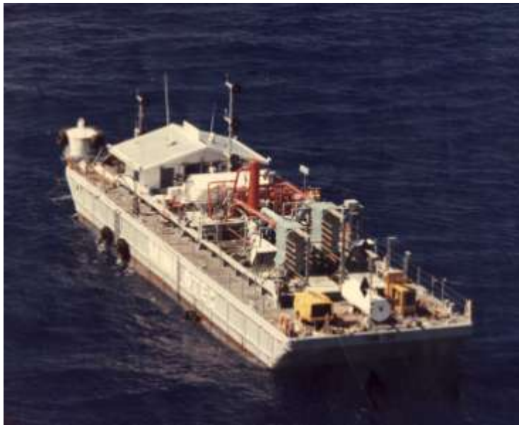
Fig. 5 : Plateforme ETM Mini-OTEC au large de l'île d'Hawaï – source photo : Luis Vega
