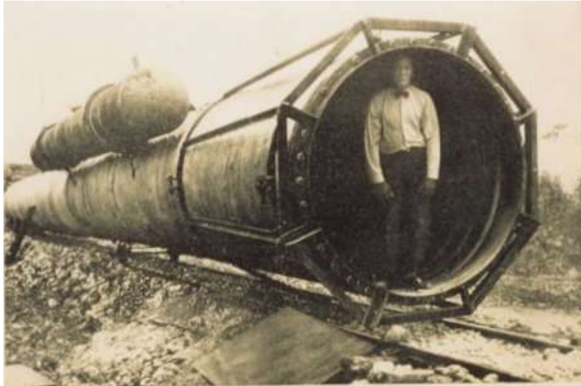
Fig. 1: Section de la CEF de 1.6 m de diamètre en cours d'assemblage à terre
