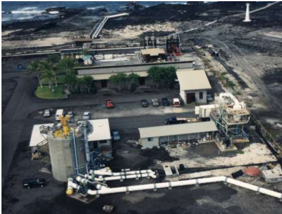
Fig. 8 : Vue aérienne de la centrale pilote ETM à cycle ouvert NPPE sur la côte ouest de l'île d'Hawaï; échangeurs de chaleurs et turbine sont situés à l'intérieur du bâtiment en béton maintenu sous vide pour permettre l'ébullition de l'eau de mer de surface – source photo : Luis Vega
