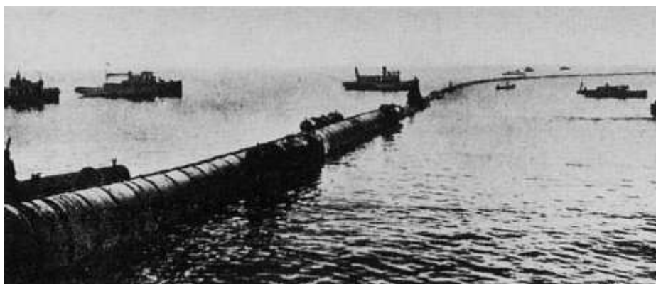
Fig. 2 : La CEF longue de 2 km avant son installation dans la Baie de Matanzas (Cuba)
